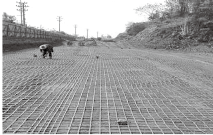
图 1.3.4 土工合成材料处置
