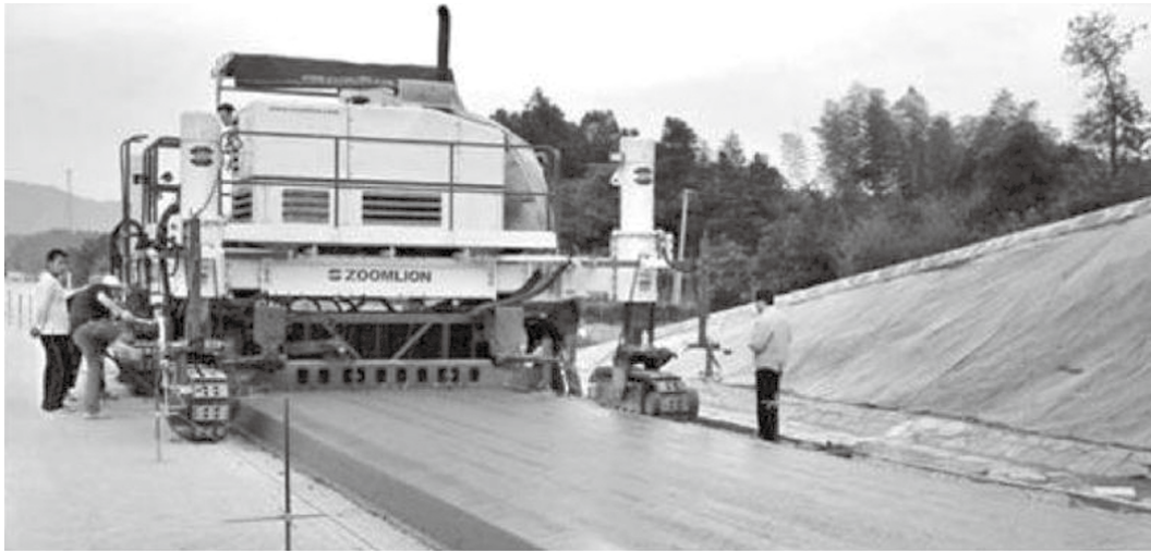
图 1.2.21 水泥混凝土摊铺机
